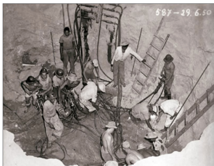
Figura 2 – Trabalhadores no início de escavação do poço adutor da CHESF (29 de junho de 1950)
